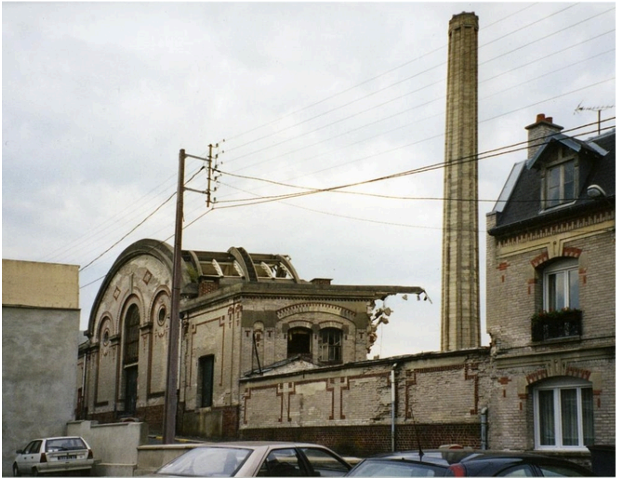
Démolition de la chaufferie, 2002.
