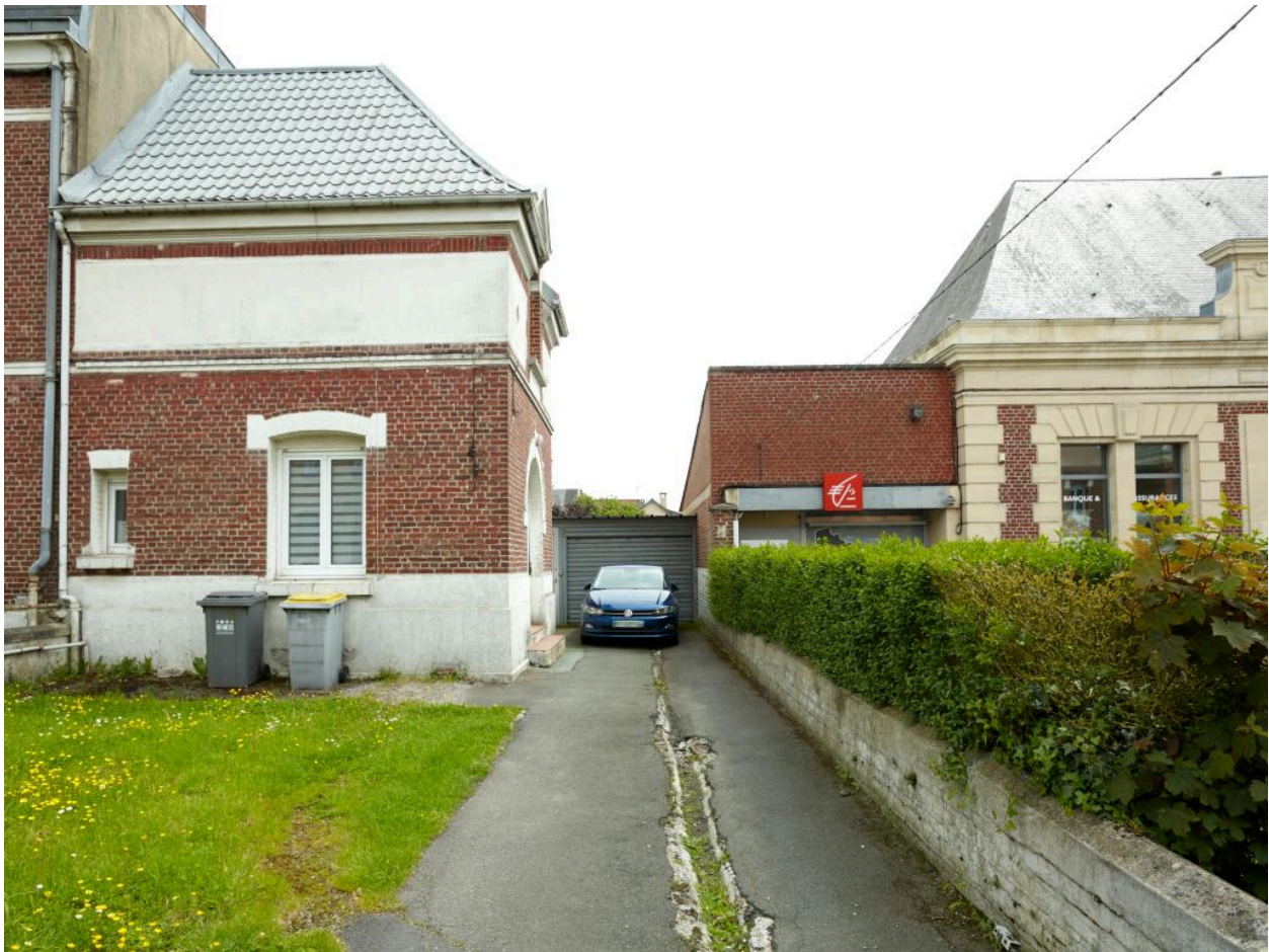
Façade de l'habitation du gardien vue depuis la rue de la République.
