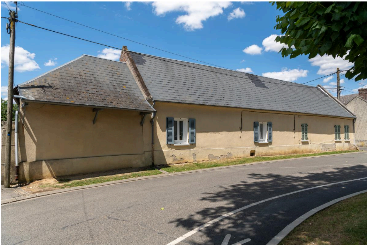
Logis en pierre, n°1 rue de l'École, vue depuis le sud-est.
