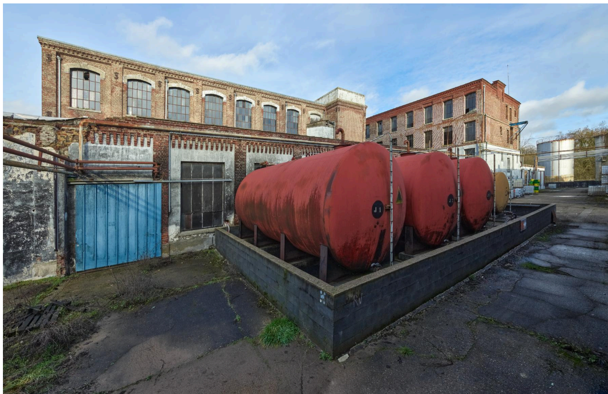
Façade sud des anciens ateliers de fabrication (bâtiment K).
