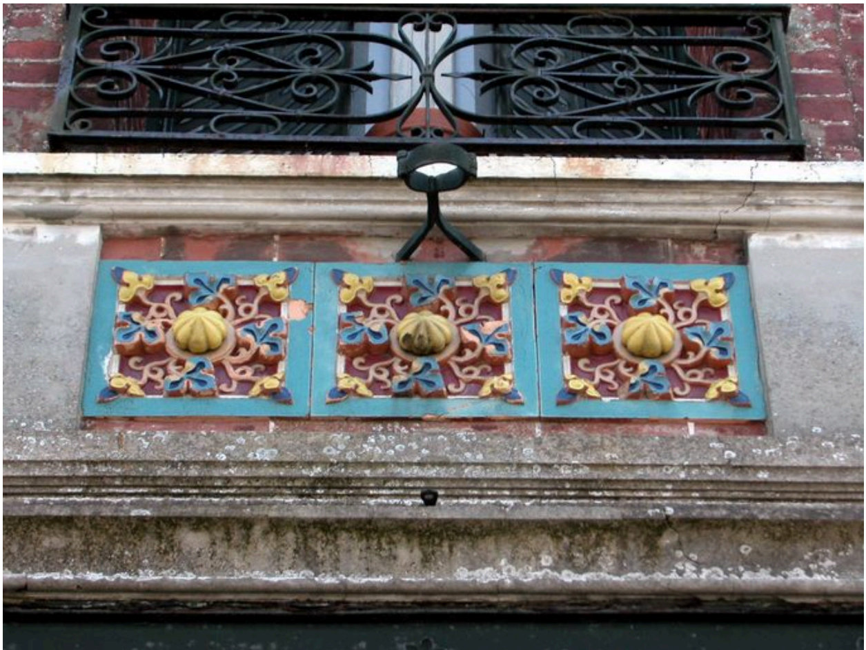
Détail d'un panneau d'allège en céramique.
