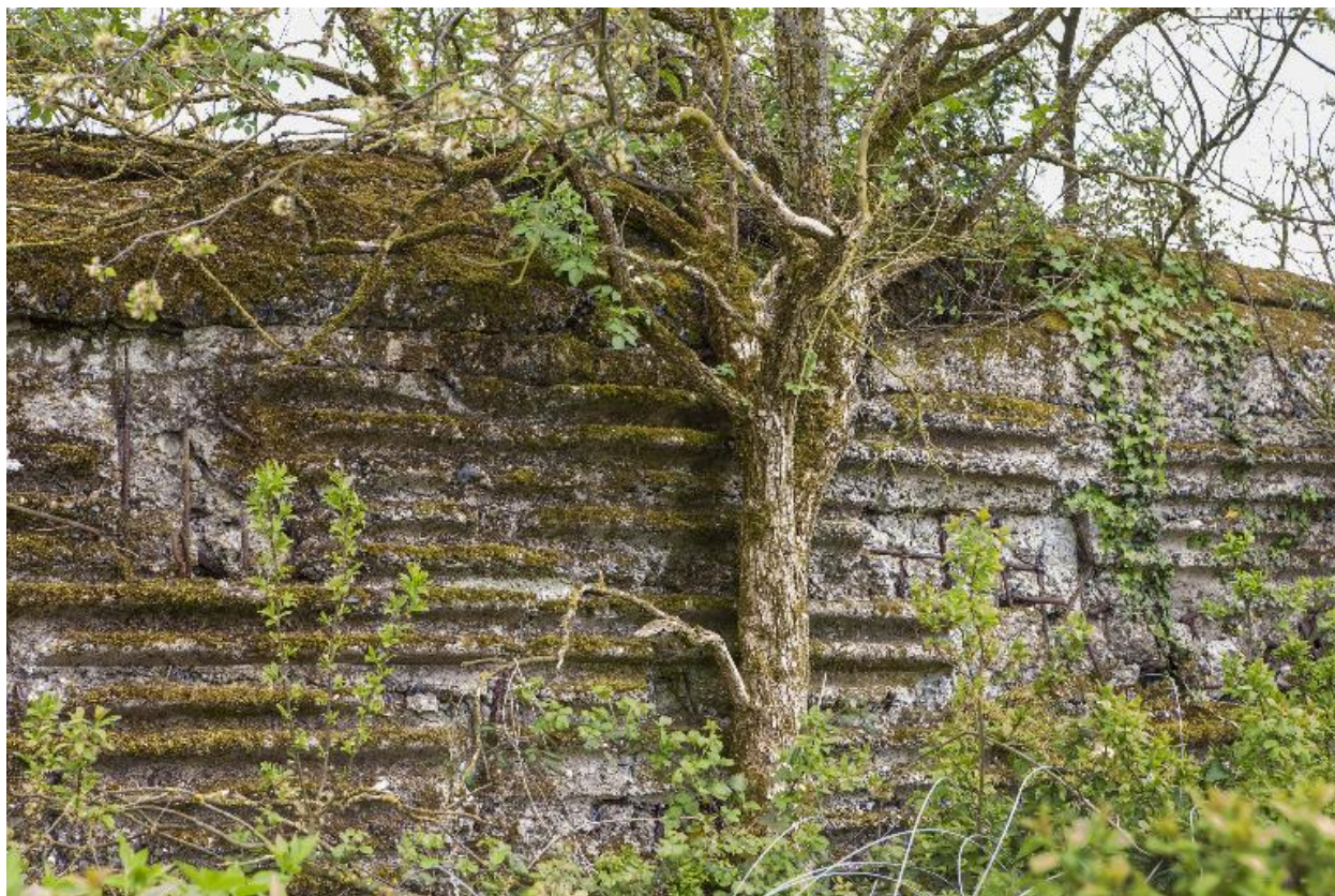
Elévation Ouest, trace de coffrage.
