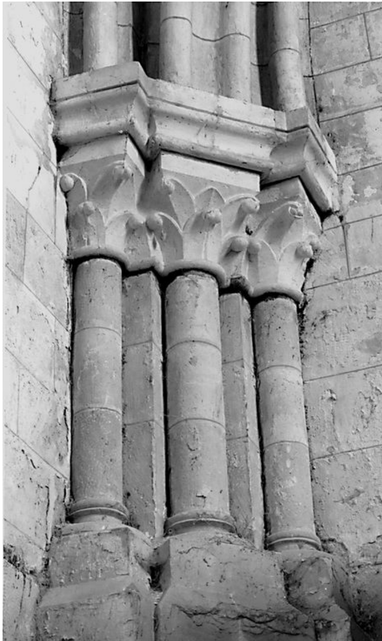
Transept nord : détail des faisceaux de colonnes supportant le départ des voûtes d'ogives.
