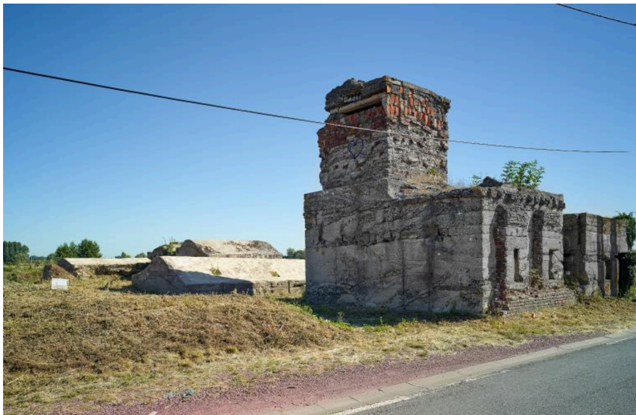
Casemate a, vers le nord-est.
