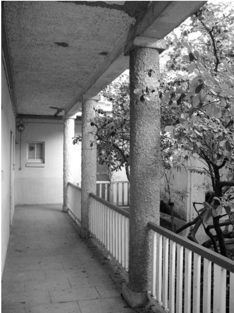
Bâtiment 520 : Détail de la coursive du rez-de-chaussée.
