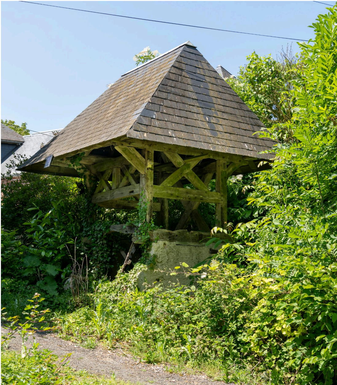
Puits, vue prise depuis le sud-est.
