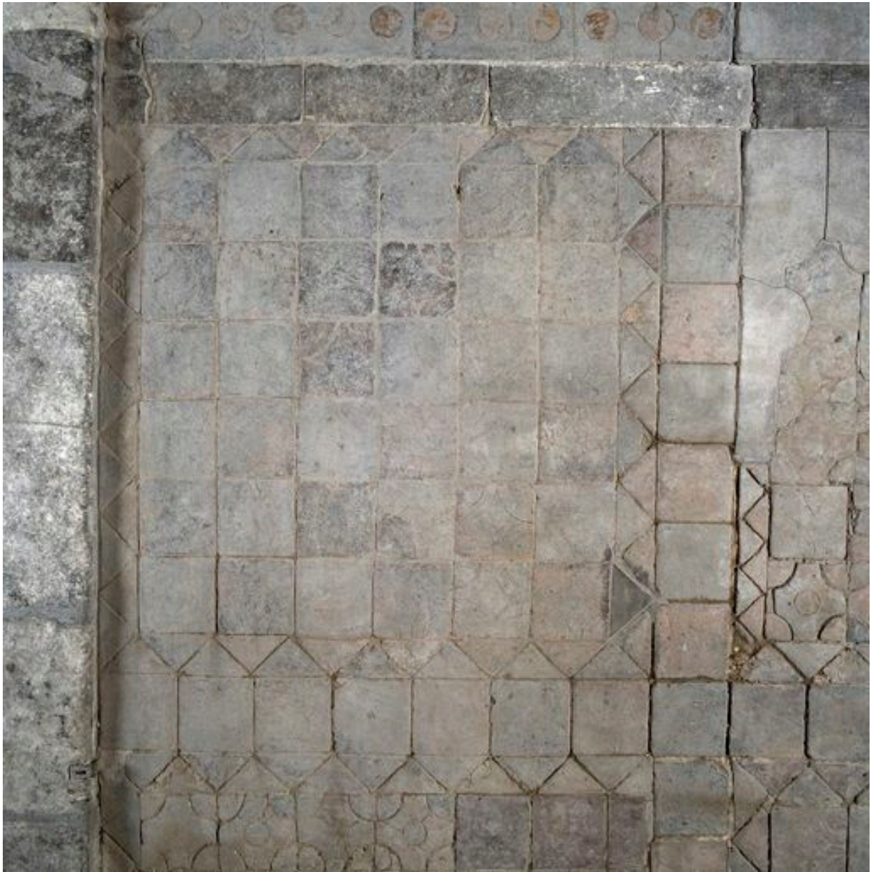
Détail du carrelage.
