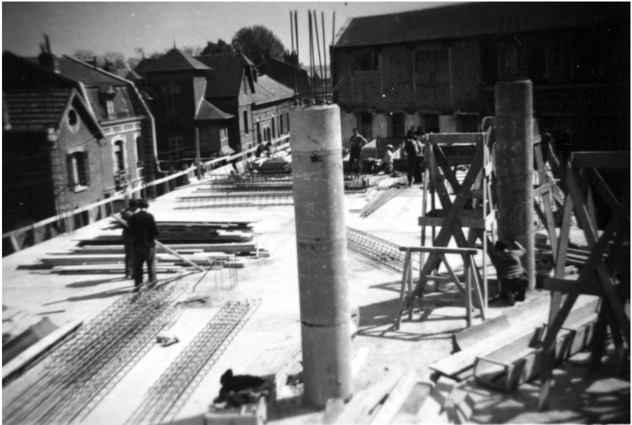
Chantier de construction des ateliers, 1948 (IFA).
