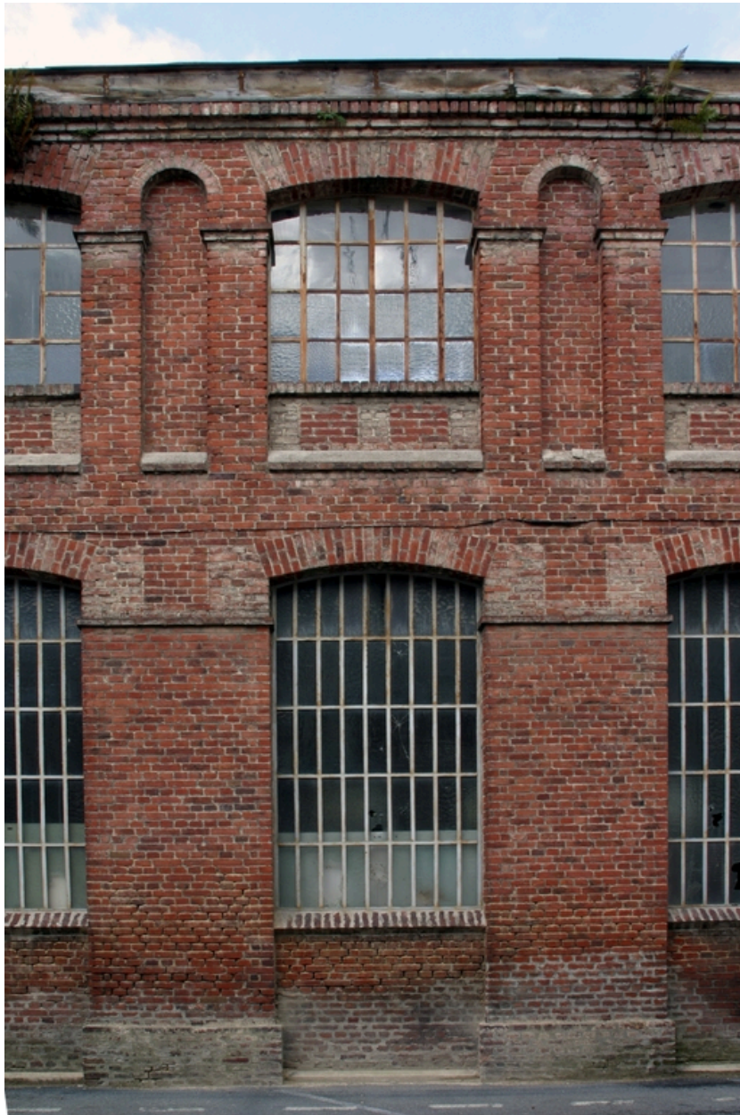
Façade antérieure des premiers ateliers de guipure (1887), rue Richard-Lenoir : détail.
