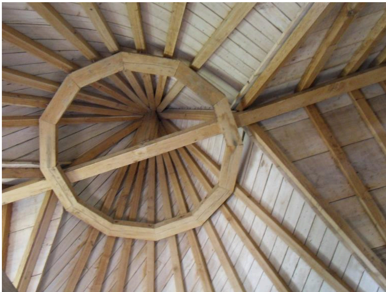
Vue de la charpente.
