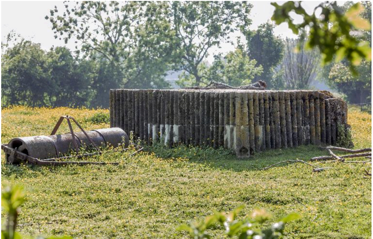
Vue arrière de l'édicule, vers le sud-ouest
