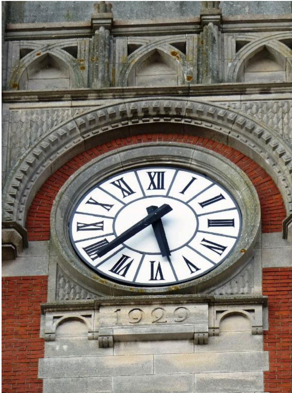
Vue de détail sur la date portée sur le clocher.
