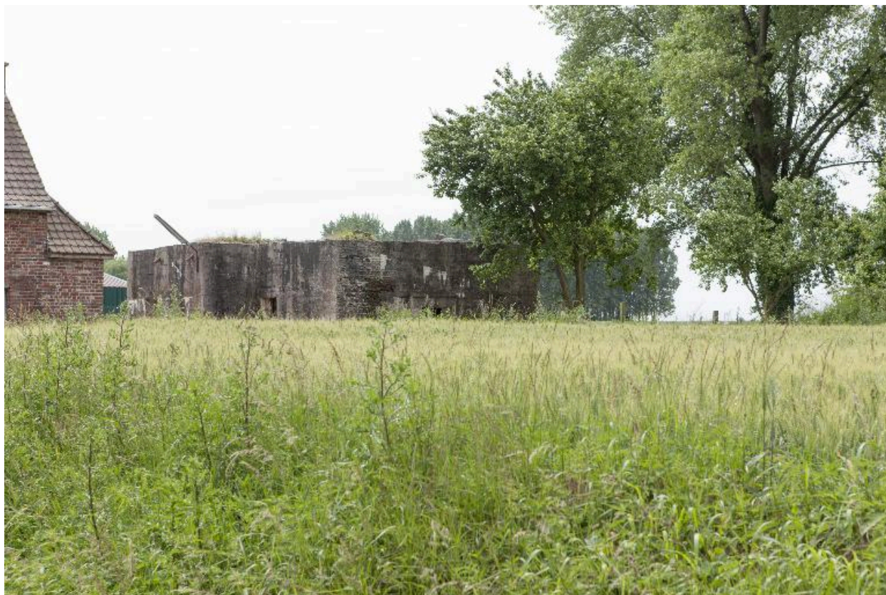
Vue de la casemate depuis la rue Pierre Semard
