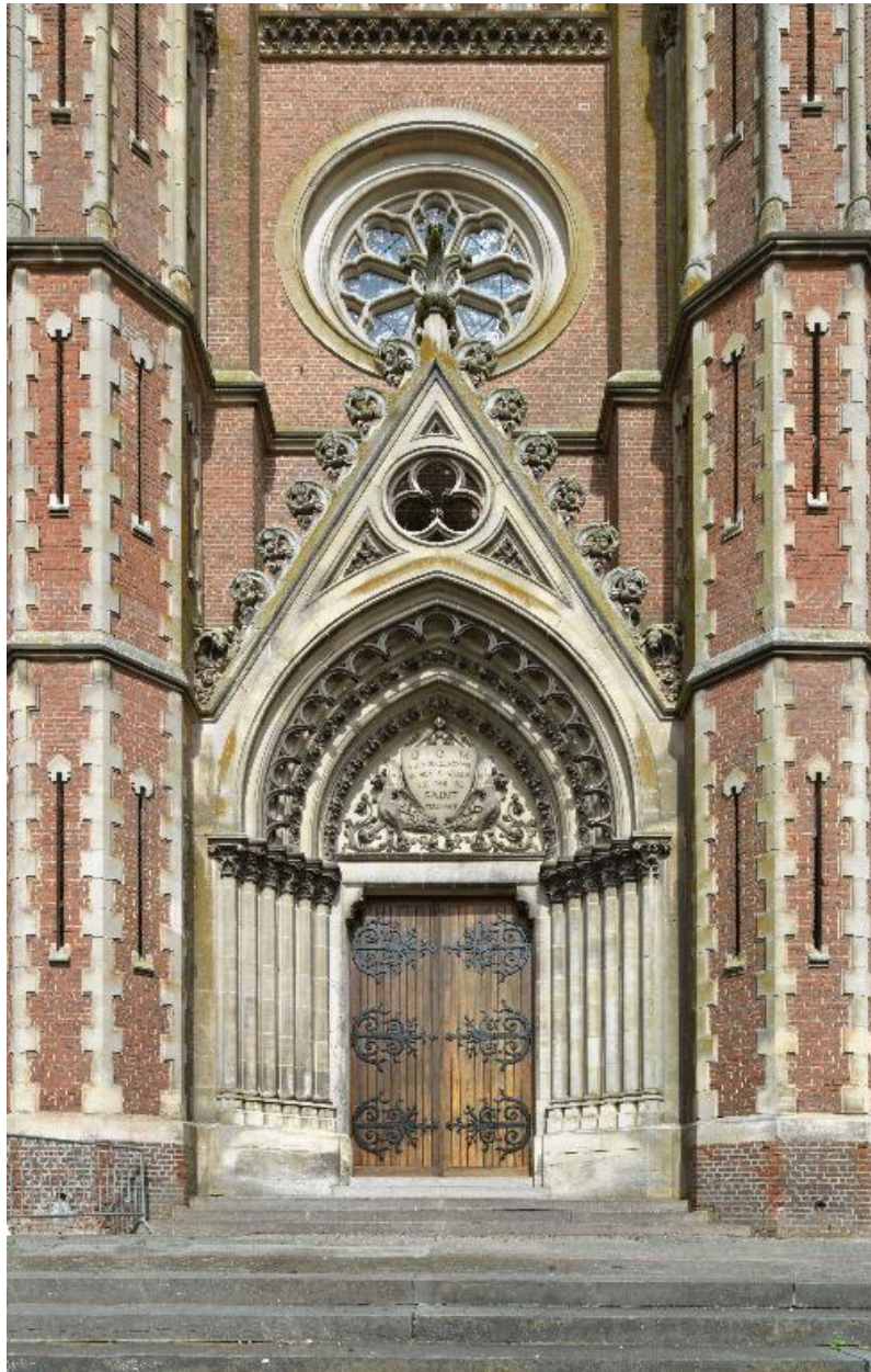
Détail du portail occidental
