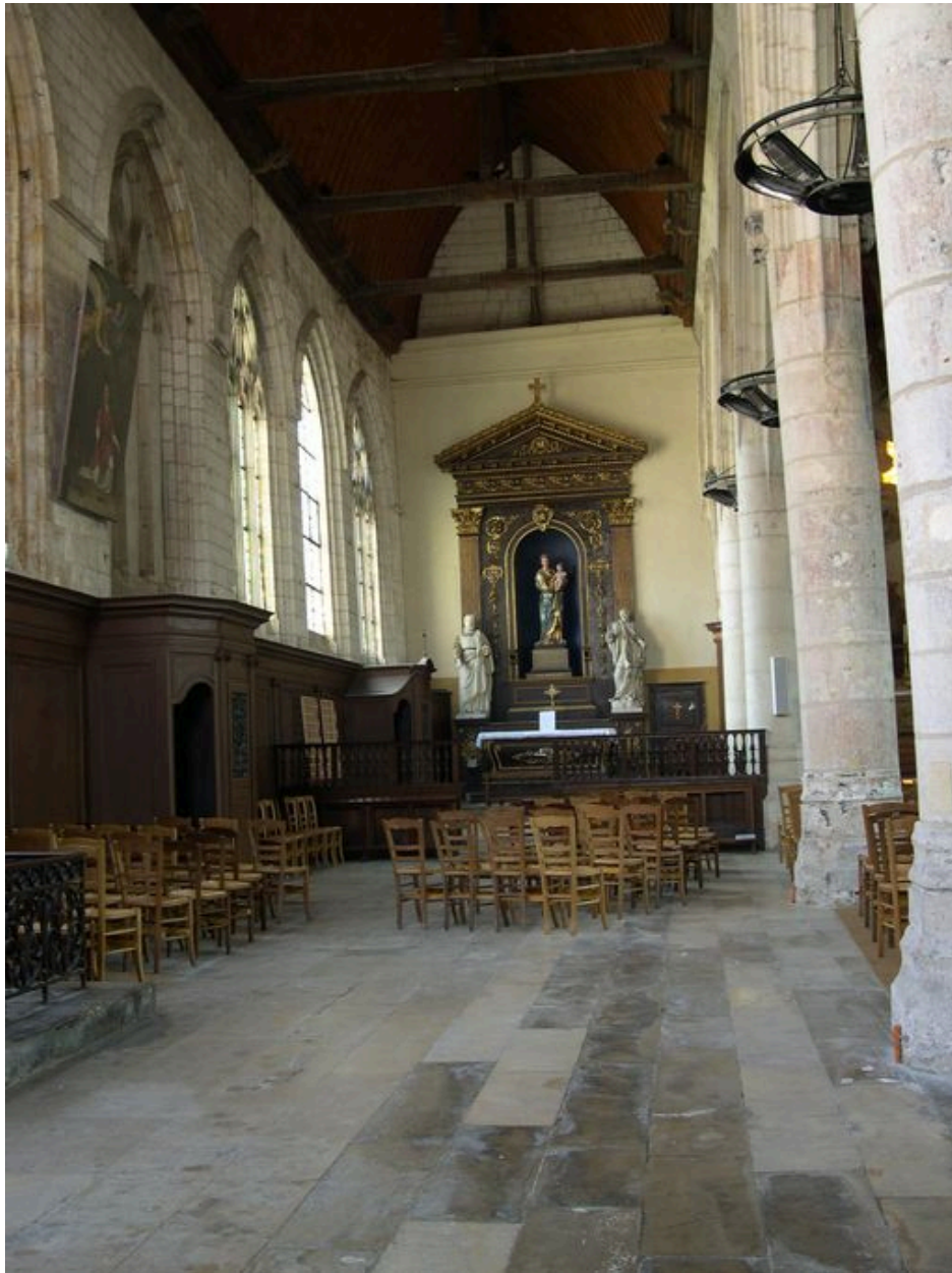
Vue intérieure : le collatéral nord.
