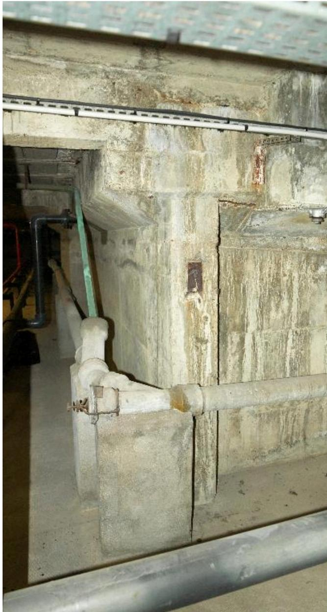
Galerie technique, vue de la cuve en béton armé du petit bassin.
