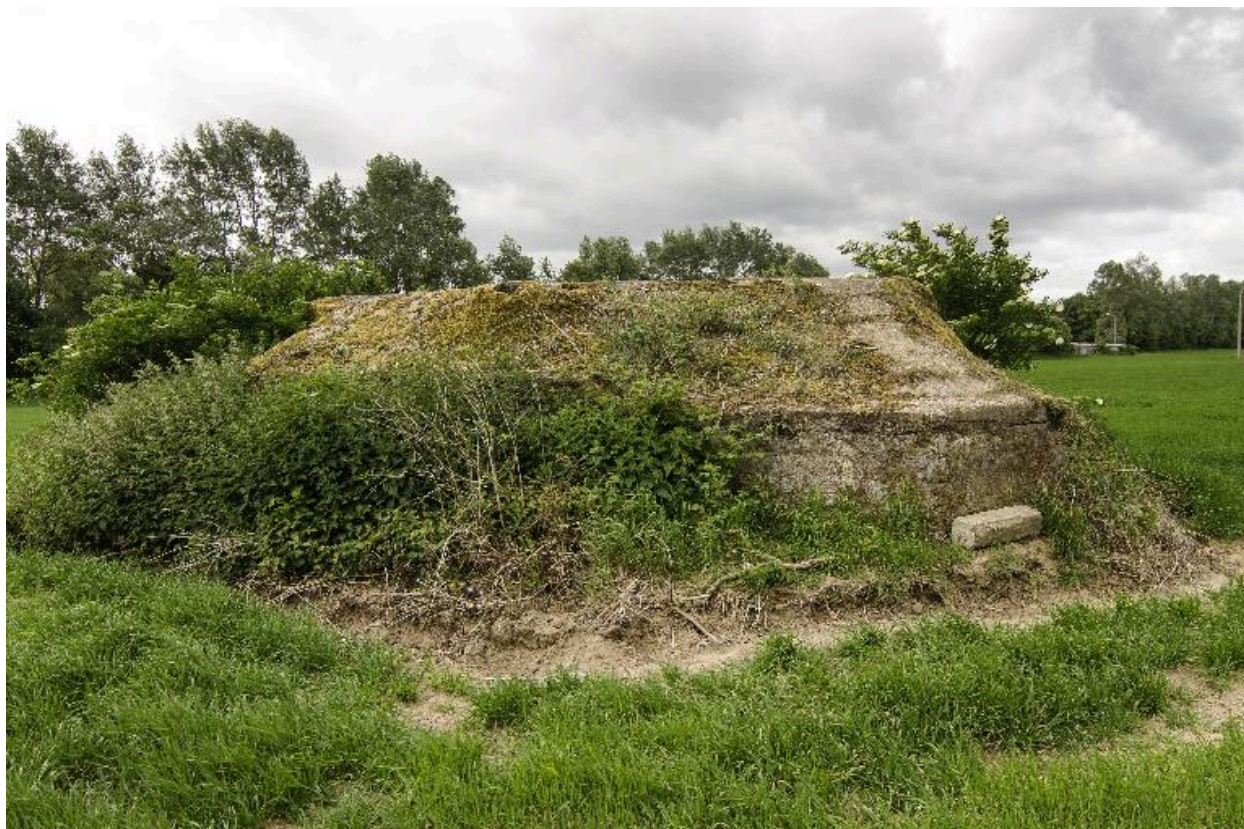
Vue de trois-quarts vers le sud.
