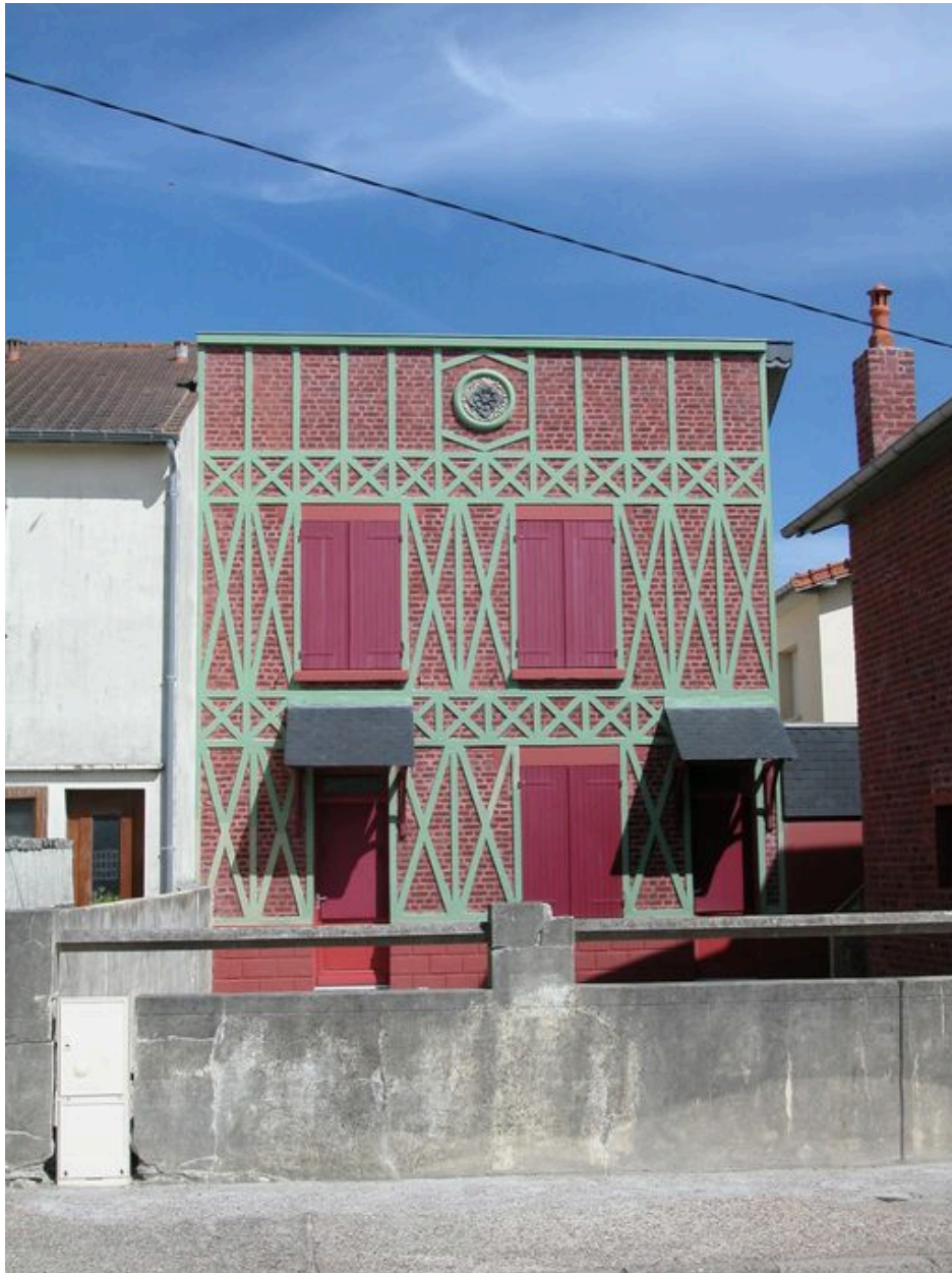
Vue d'ensemble de la maison située en fond de parcelle, après restauration.
