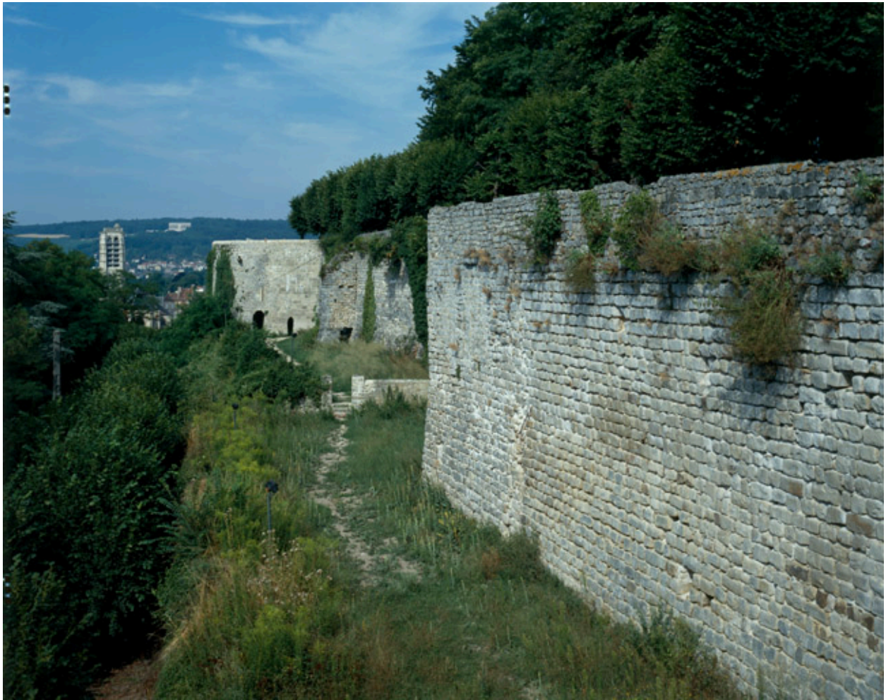
Vue générale des remparts, côté sud.
