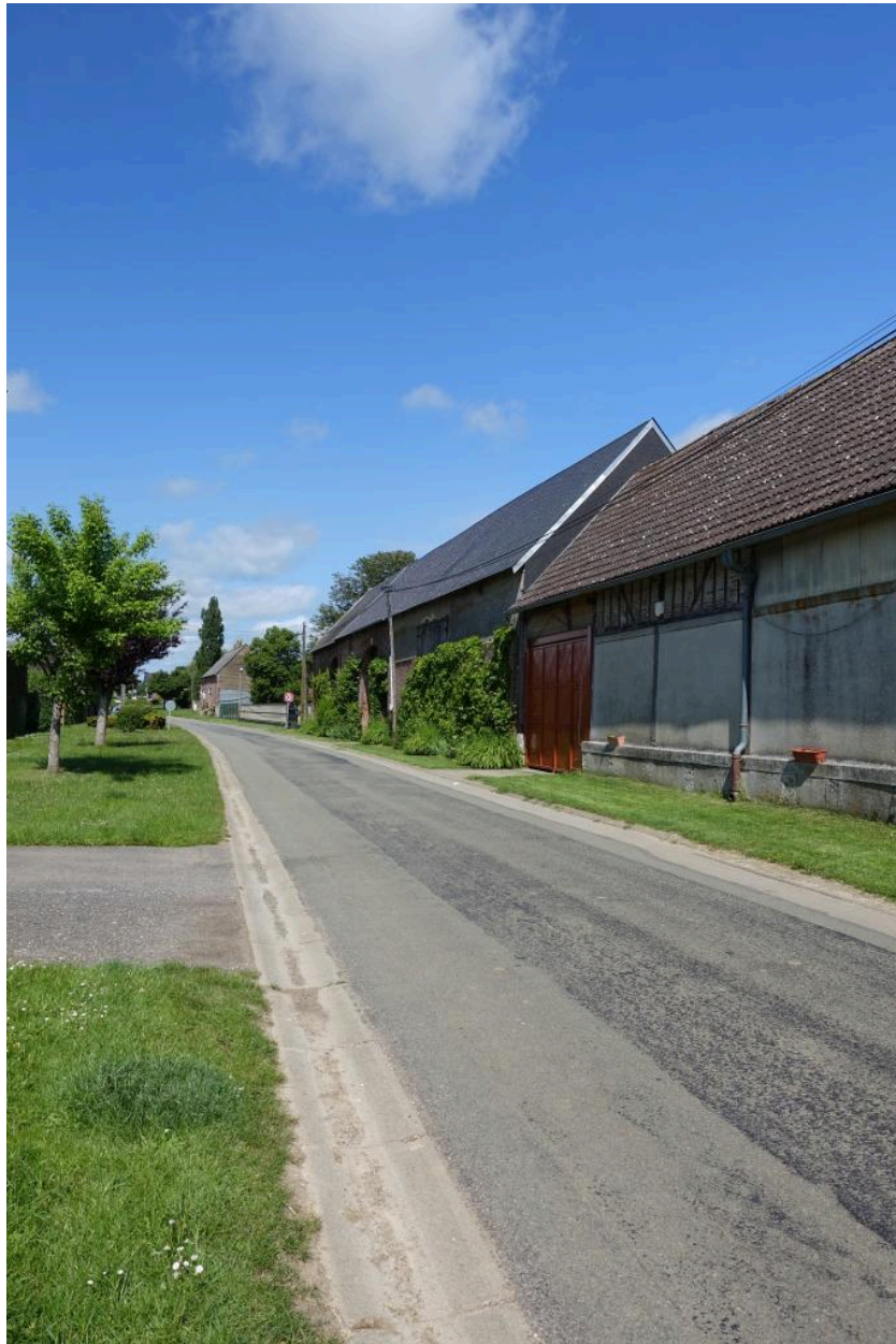
Vue générale depuis l'est de la rue du Pressoir avec l'usoir à gauche, vers le n°9.
