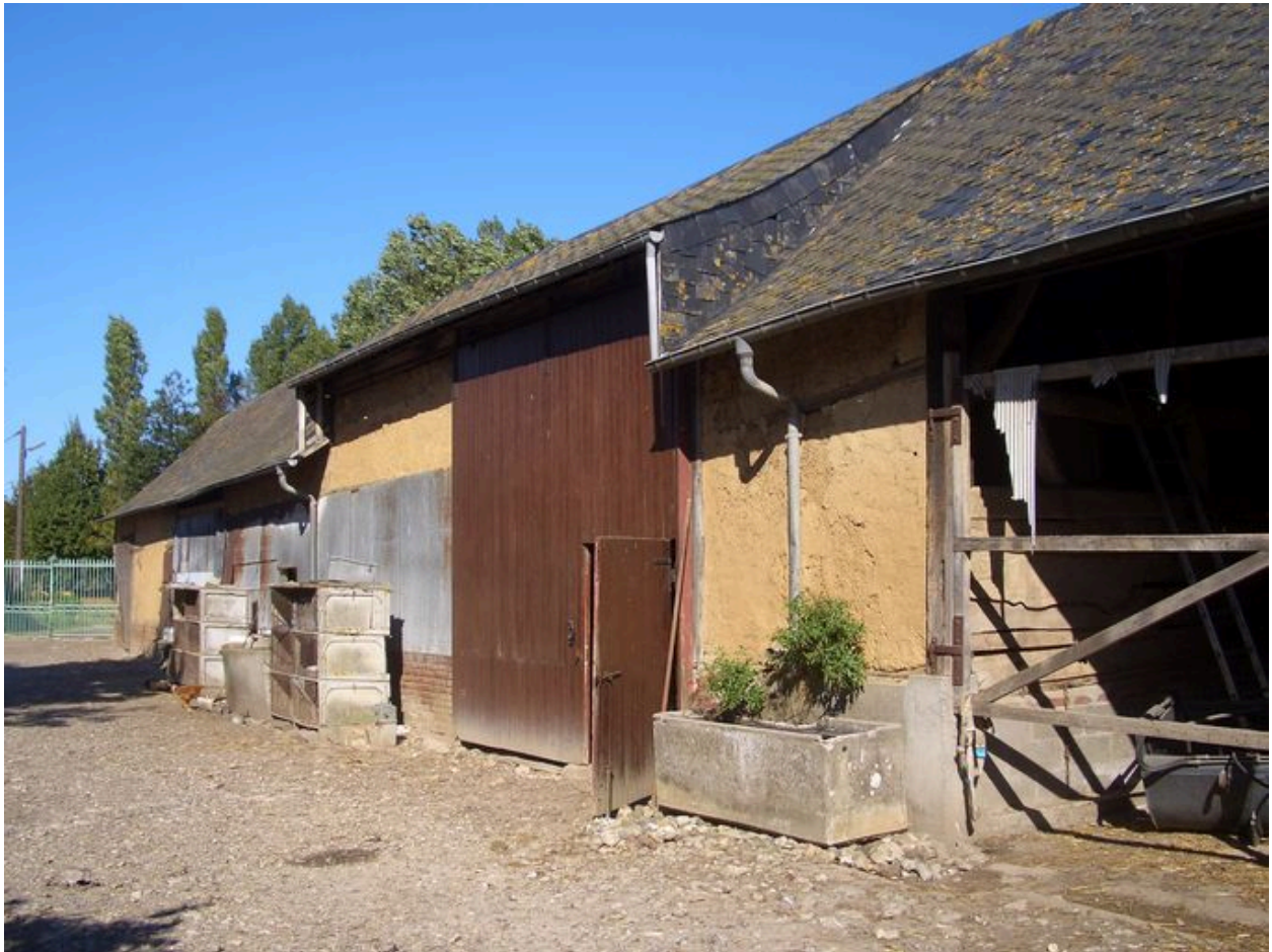
Vue de la partie centrale de la grange.
