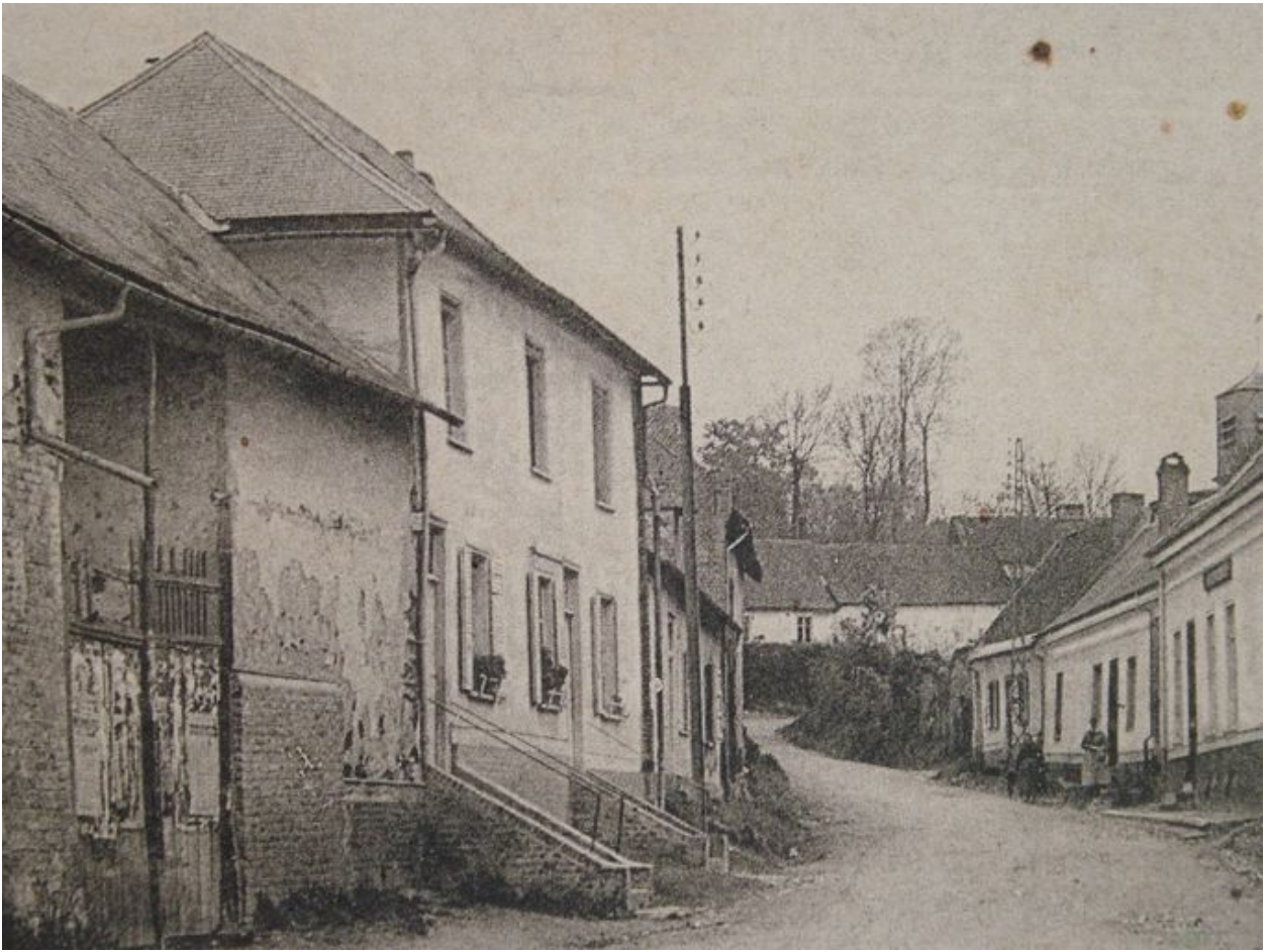
Vue de situation depuis la rue, avant 1914 (coll. part.).
