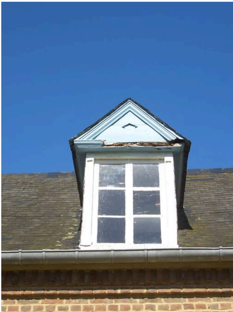
Vue détaillée d'une lucarne.
