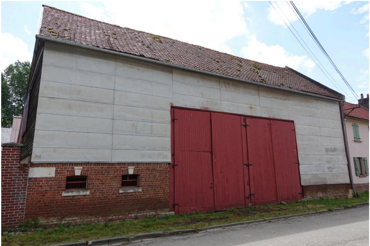
Grange sur rue, n°10, vue depuis l'ouest.
