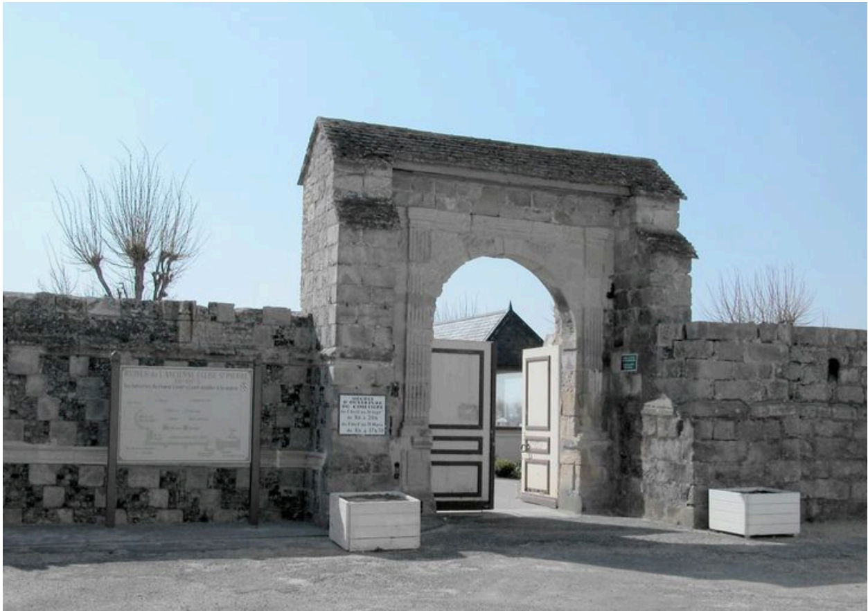
Vue de l'ancienne porte du bas-côté nord de l'église paroissiale en ruines, depuis l'extérieur.
