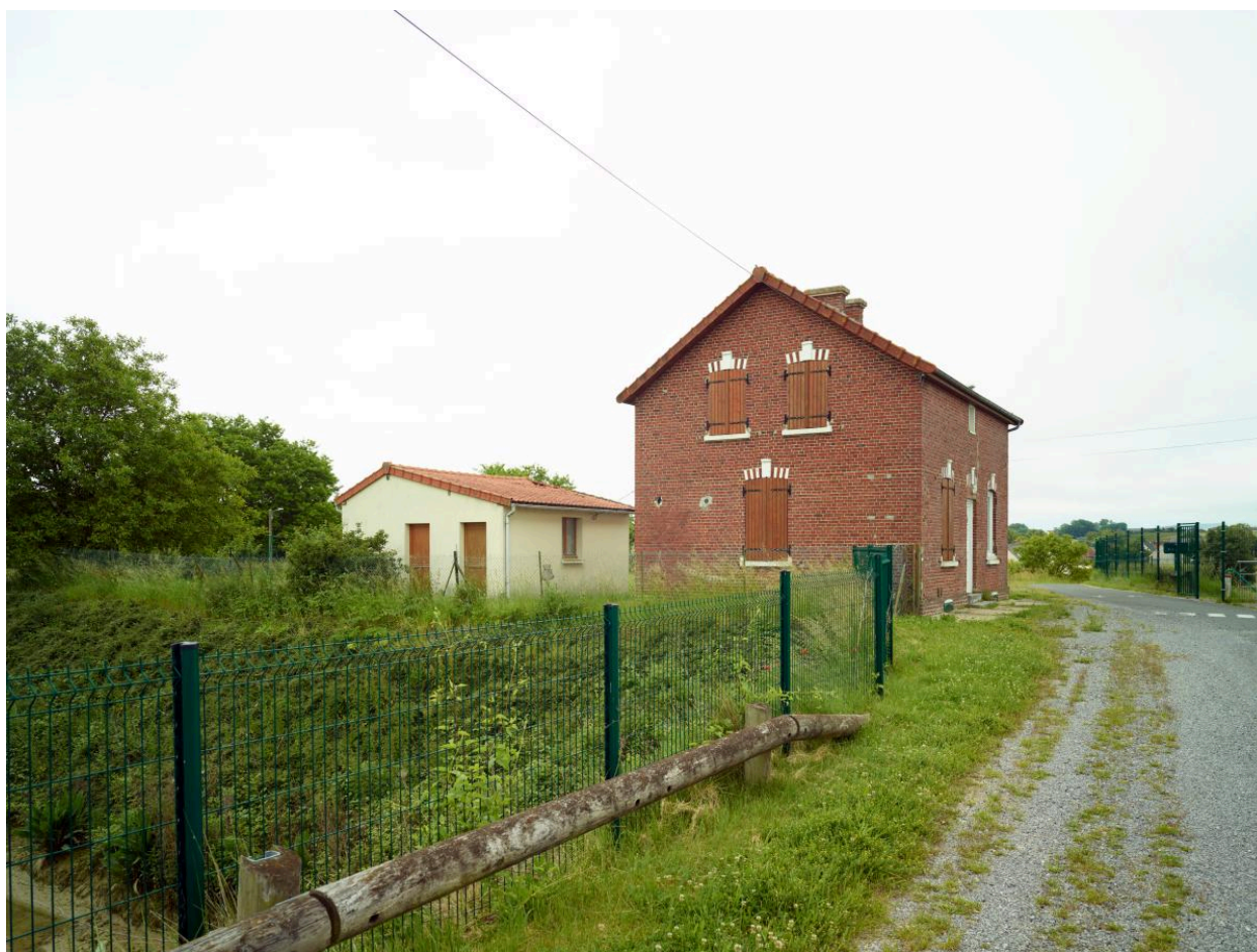
La maison de service (aval).
