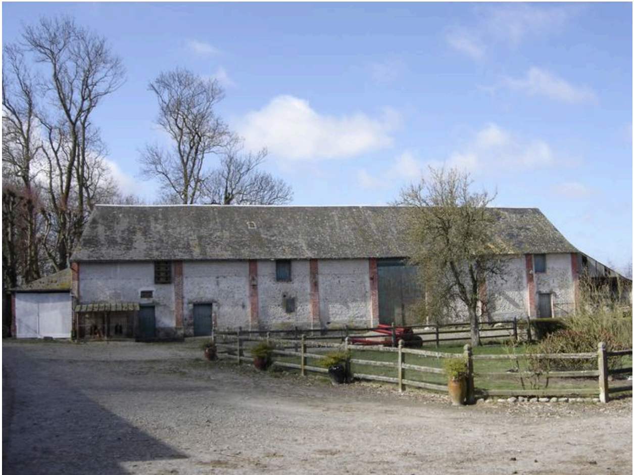
Vue de la grange depuis la cour.
