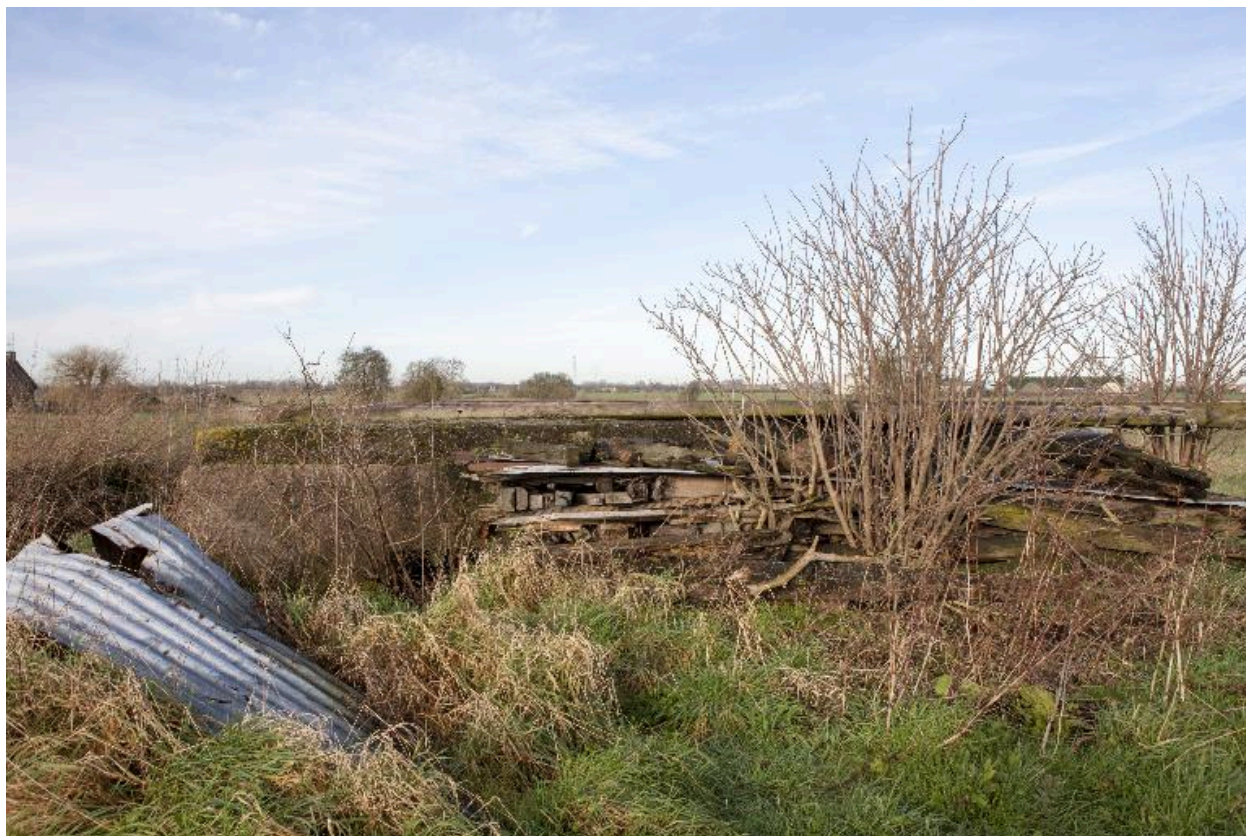
Casemate B : Vue générale, vers l'ouest
