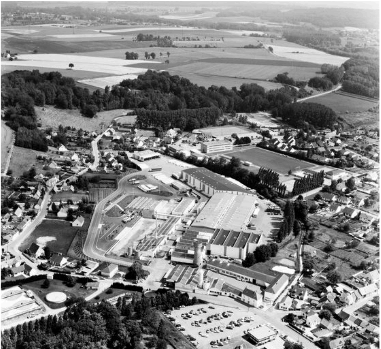
Vue aérienne depuis le nord, en 1991.
