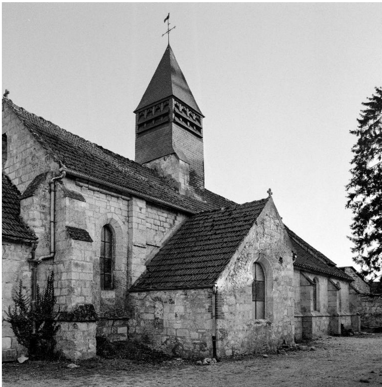
Vue de l'élévation nord de l'église.
