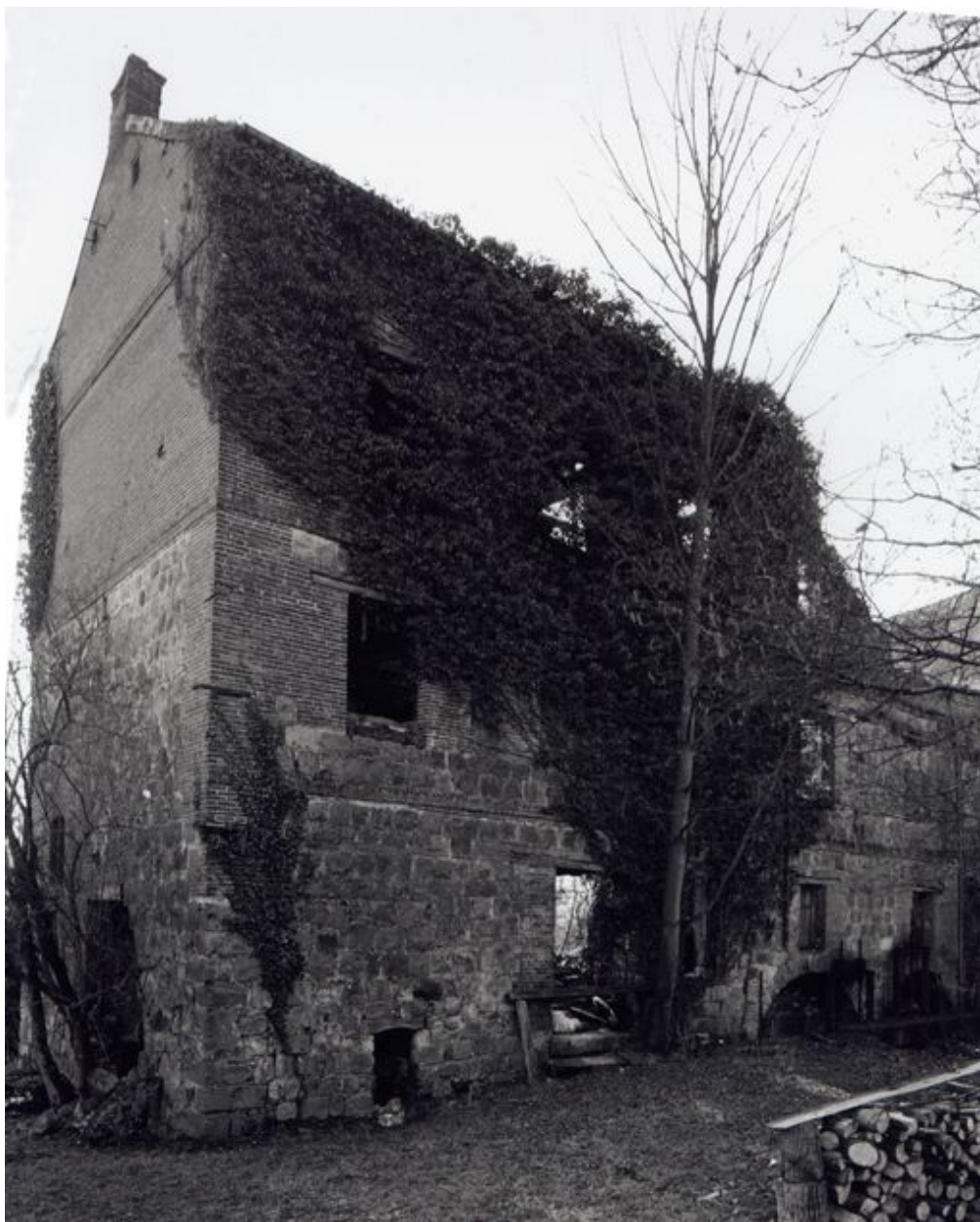
Elévation nord du moulin, vue d'ensemble.
