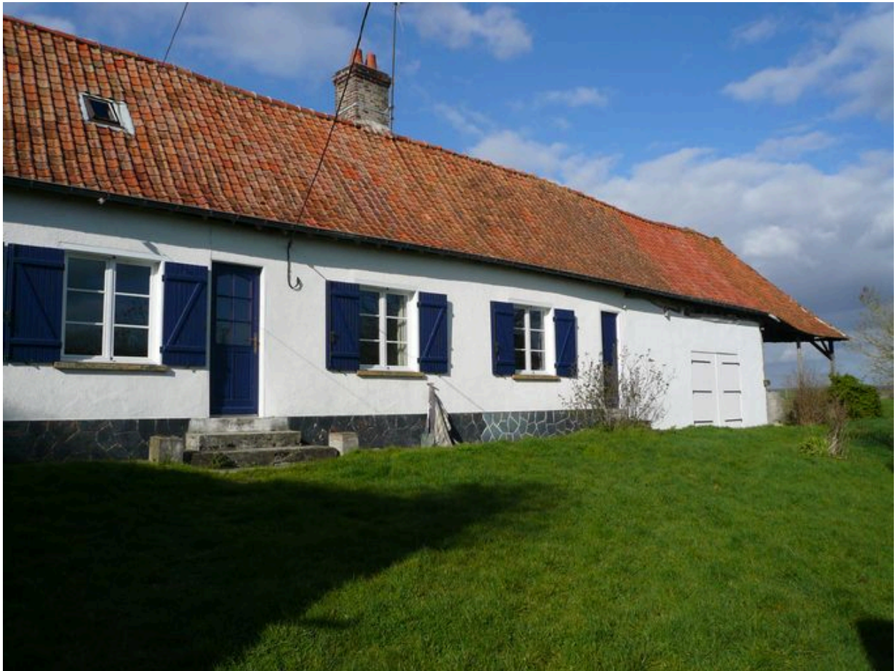
Vue de la charretterie dans le prolongement du logis.
