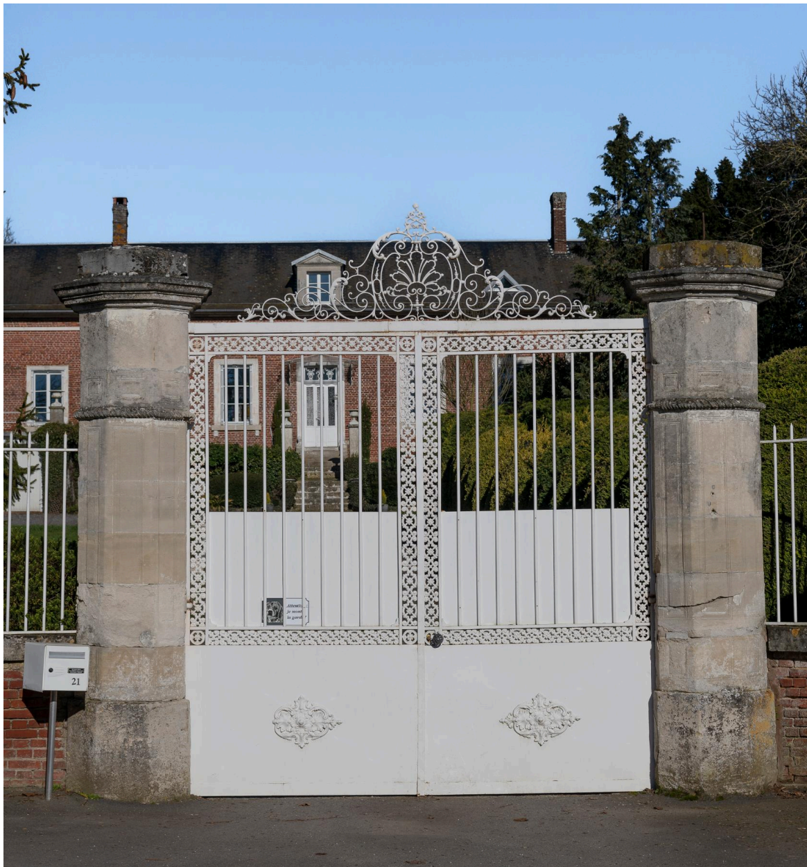
Portail, n°21 rue de l'Église, vue prise depuis le sud.
