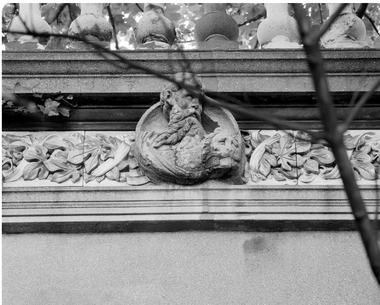
Façade sur voie, tête (céramique).
