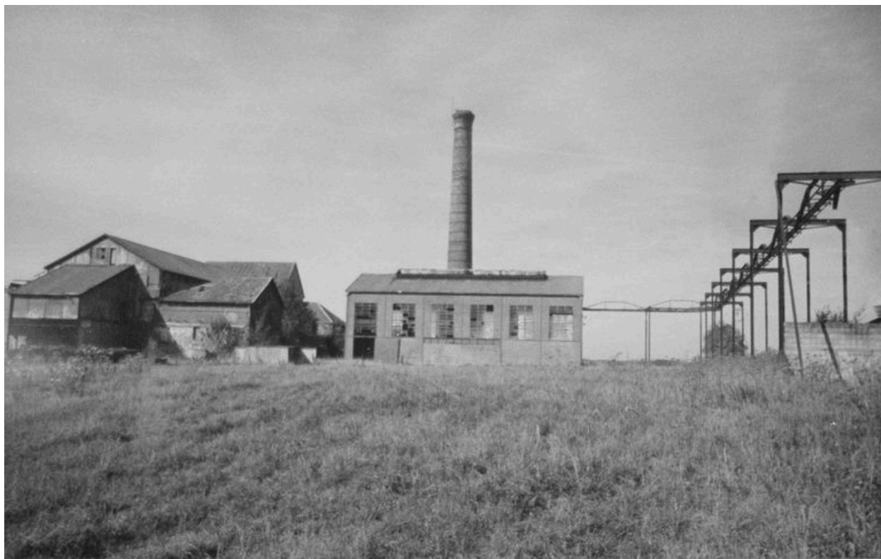
Vue de la chaufferie et du transporteur aérien, vers 1950 (AP).
