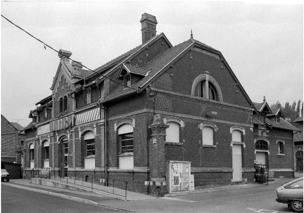
Magasin de commerce, élévation antérieure.
