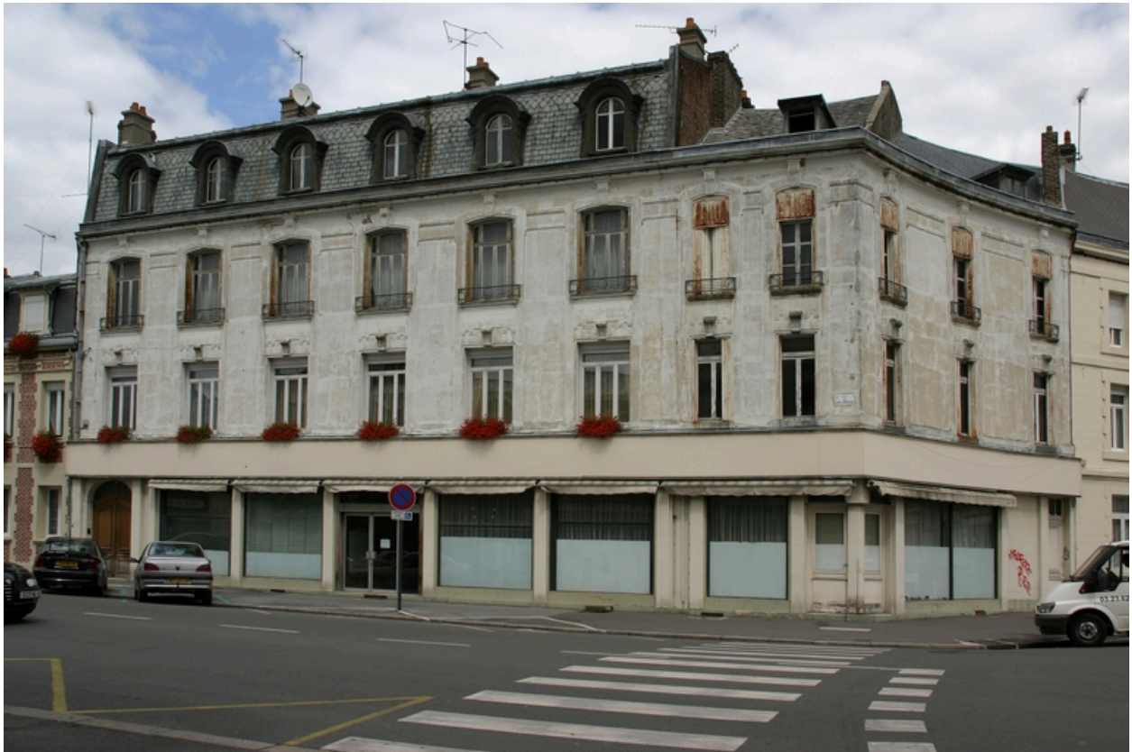
Façade antérieure, rue des Etats-Généraux.
