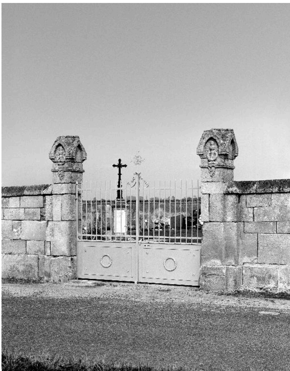
Vue de la porte d'accès.
