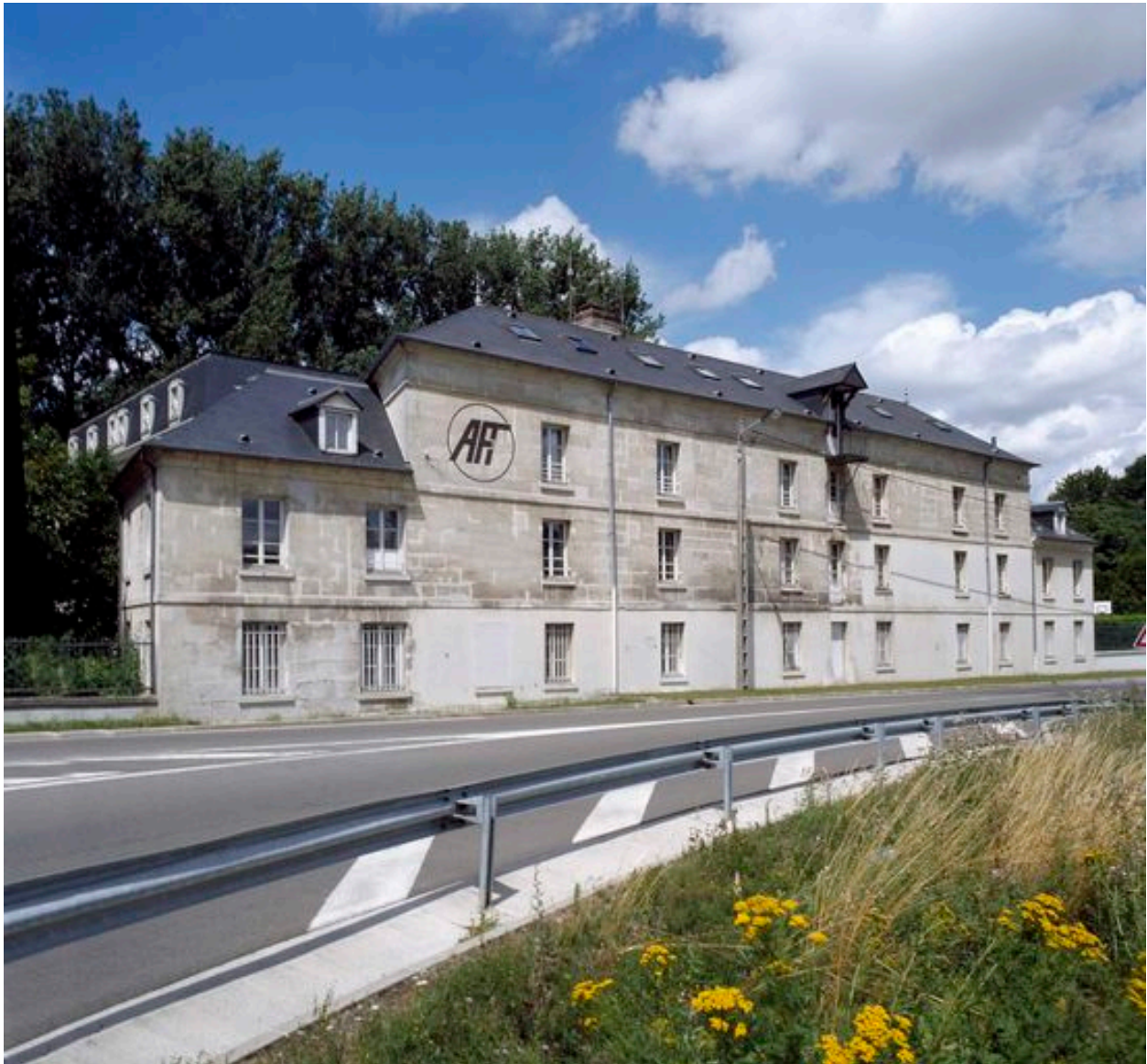
Façade postérieure du moulin Mazeau.
