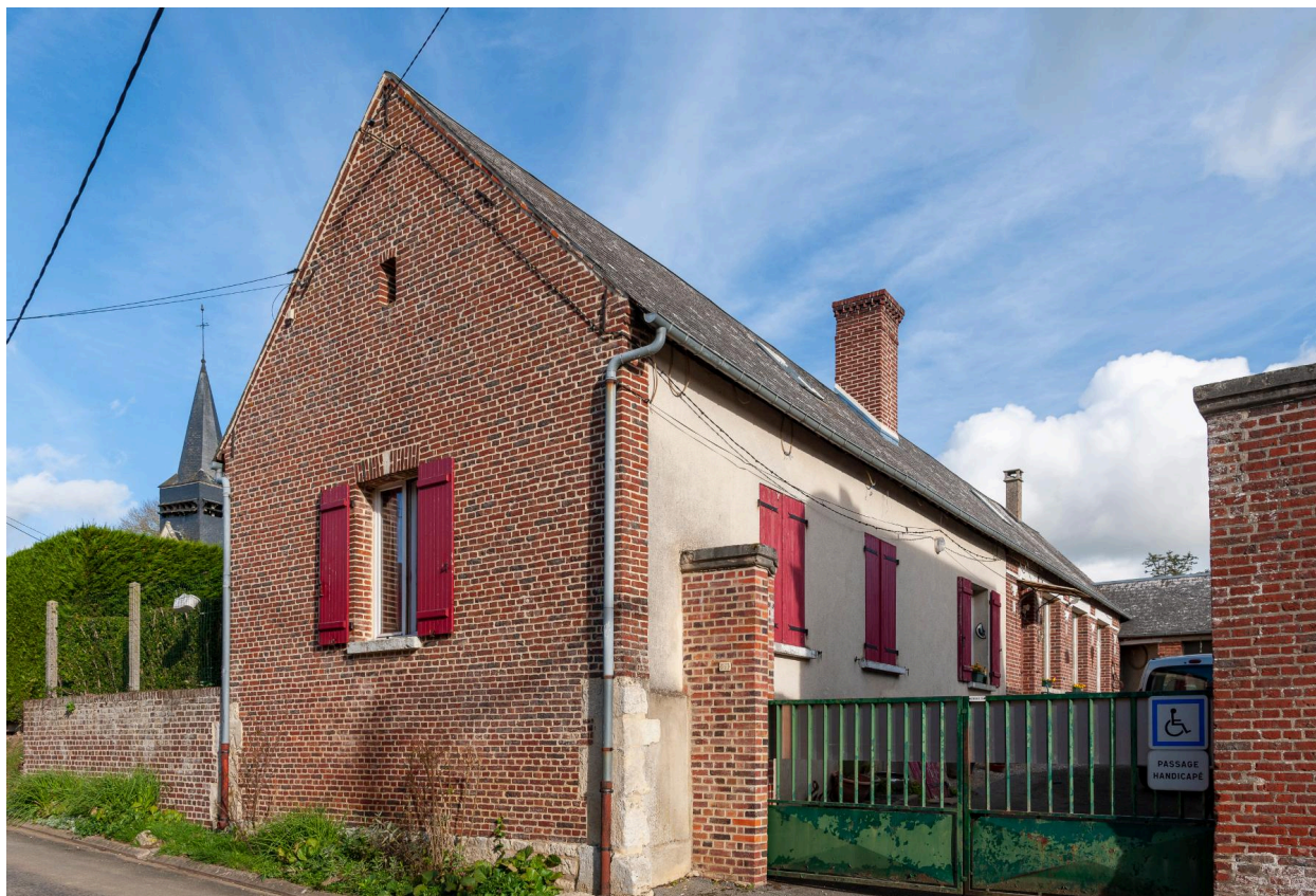
Ancienne école, vue depuis le sud-ouest.
