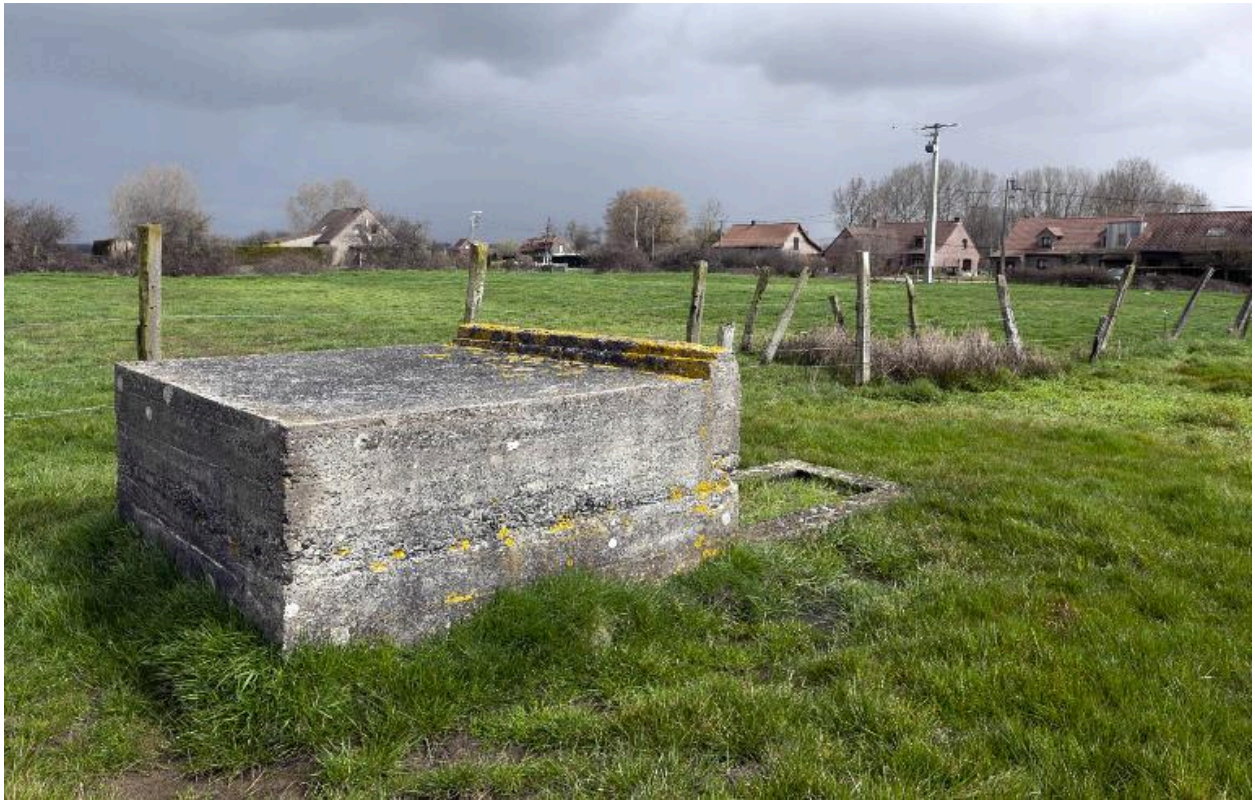
Vue de trois-quarts vers le nord-est
