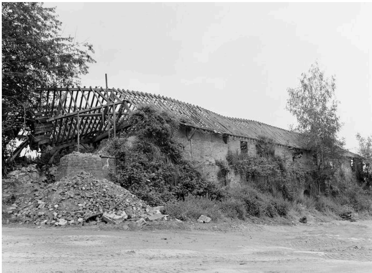
Four industriel de type Hoffmann, côté sud.
