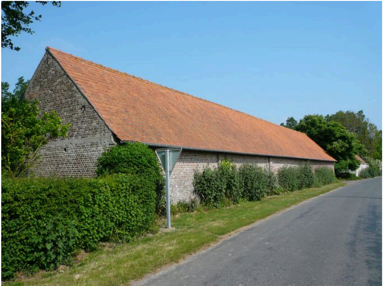
Vue des étables situées au nord de l'entrée depuis la rue.
