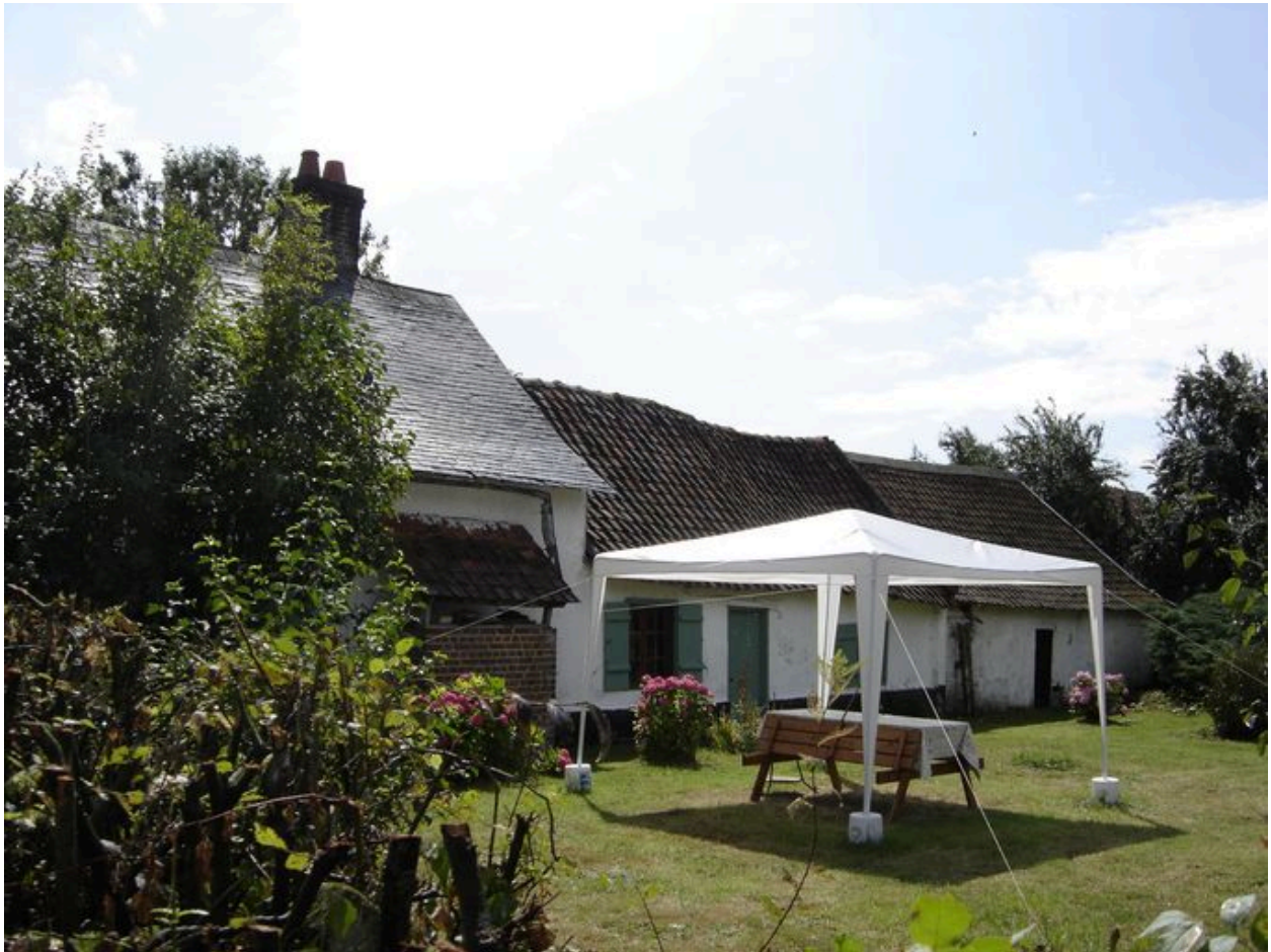
Vue générale postérieure.
