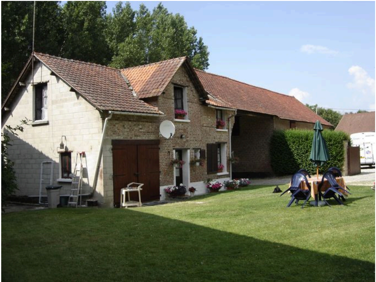
Vue des étables surmontées d'un fenil.
