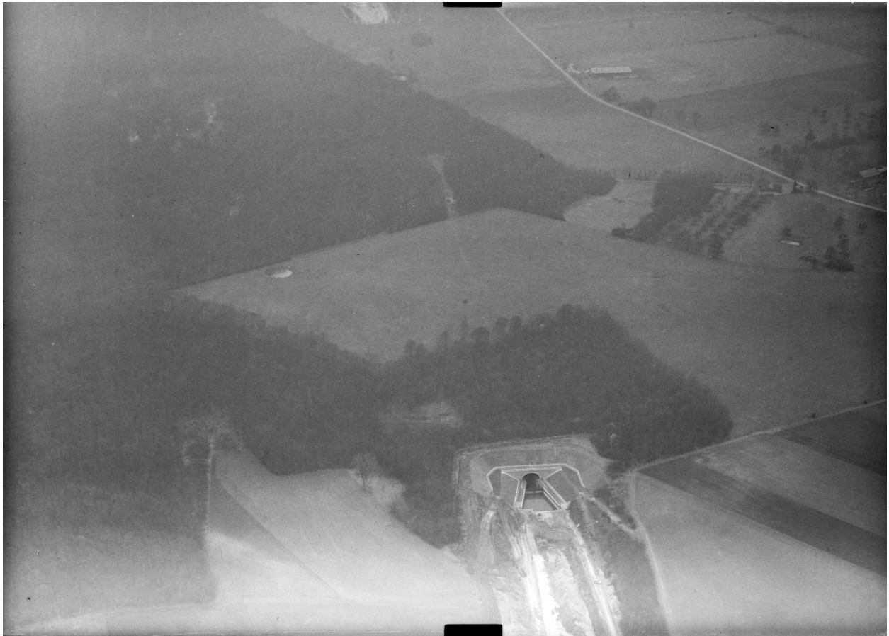
Vue aérienne des environs de la tête nord du souterrain de la Panneterie sur le canal du Nord à Libermont (Oise) reprise durant le second chantier du canal, 1963.
